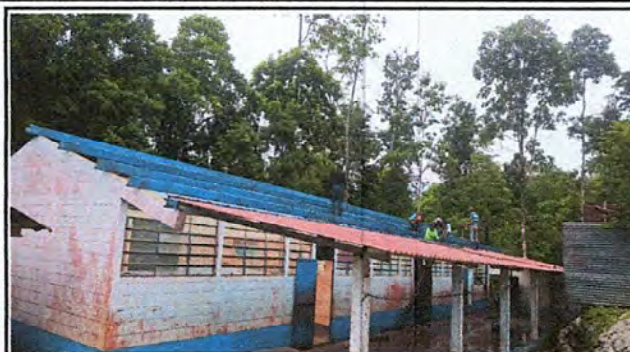
Foto 2: Cambio de techo de las tres aulas principales más una dirección y dos bodegas.
