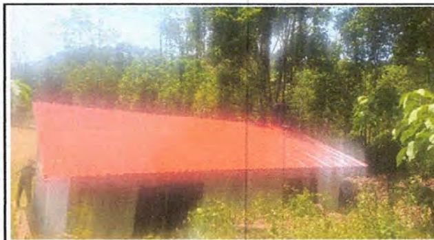
Foto 4: Aula de preprimaria en estado de ejecución.
