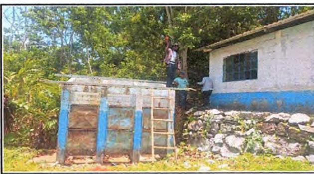
Foto 5: Entechado de los dos módulos de letrinas.
