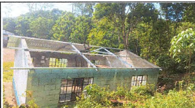
Foto 3: Cambio de techo del aula de preprimaria.
