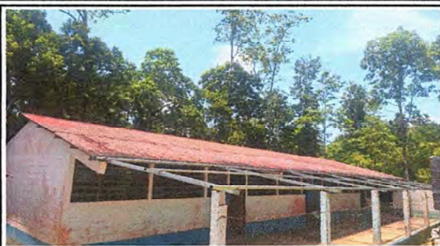
Foto 1: Cambio de techo del corredor o patio del edificio escolar.
