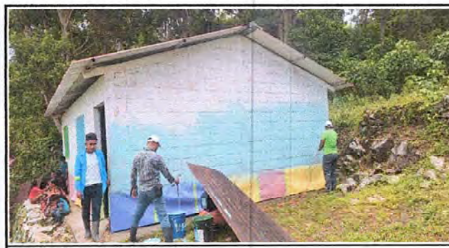
Foto 6: Pintura de todas las aulas.
